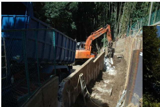
重機で擁壁の復元工事 上 →右
