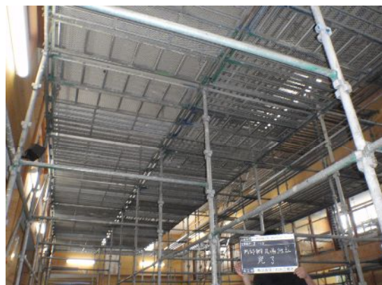
室内壁崩落で足場組んだ保育室
